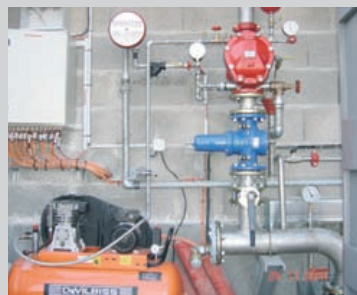
Poste sous air (si risque de gel)
